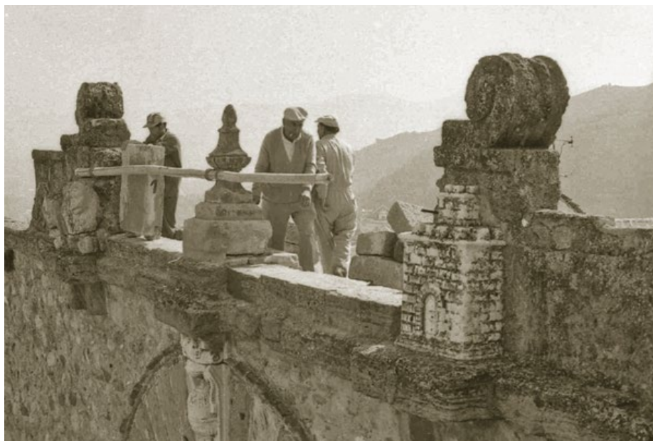
Figura 16. Trabajos de restauración para la celebración del IV centenario de la construcción del monumento; el león a la izquierda de la imagen. Archivo Durán. Oficina Técnica de Arqueología de Antequera
